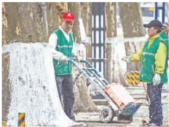
工作人员正在进行喷涂作业 记者周迪 摄
