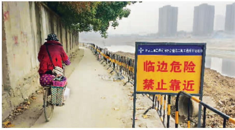
12月15日完工后就进行道路恢复施工,若条件允许,此路会改造成绿道 记者杨荣峰 摄
